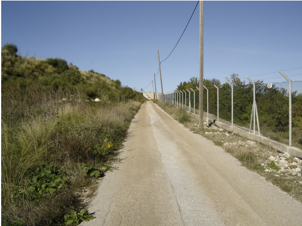
Asfaltirani put do nogometnog igrališta i ograda airside dijela zračne luke
