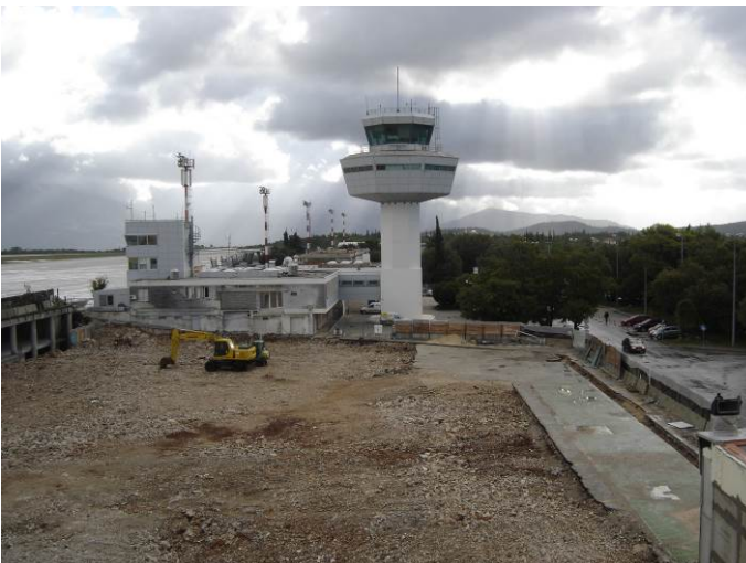
Gradilište zgrade C (oznaka 3) – landside ( Izvor: web ZLD )
