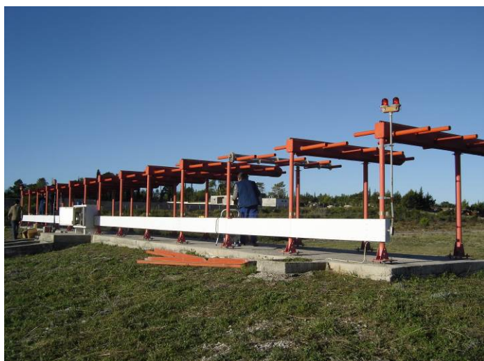
Prilog 94: Antenski sustav - LOKALIZER (ILS 12) (Izvor: Trames d.o.o., listopad 2012.)
