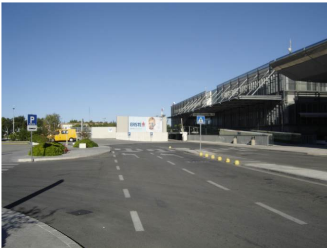
Prometnica uz zgrade A i B zapadu
