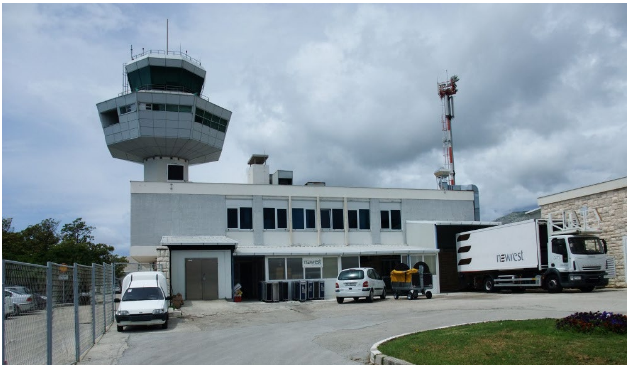
Prilog 30: Fotografija postojeće zgrade za opskrbu zrakoplova hranom i pićem (Izvor: MasterPlan @ Airport Consulting Vienna GmbH)
