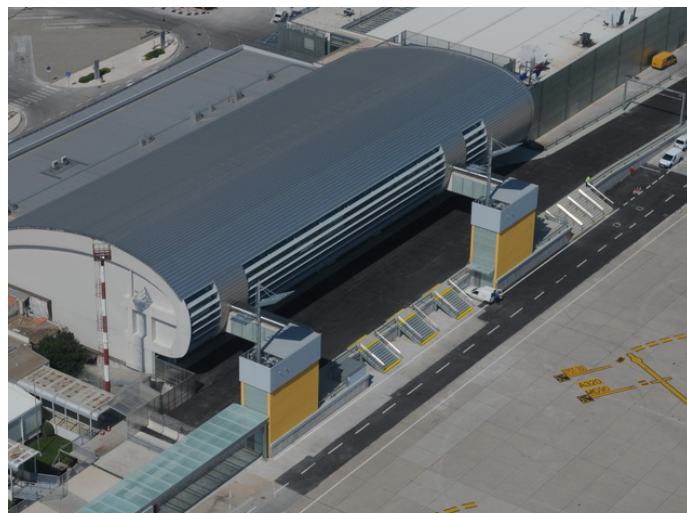
Zgrada B i dilatacija „T“ (oznaka 3a) - airside
