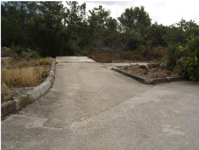
Podzemno odlagalište zrakoplovnog fekalnog otpada (oznaka 21)
