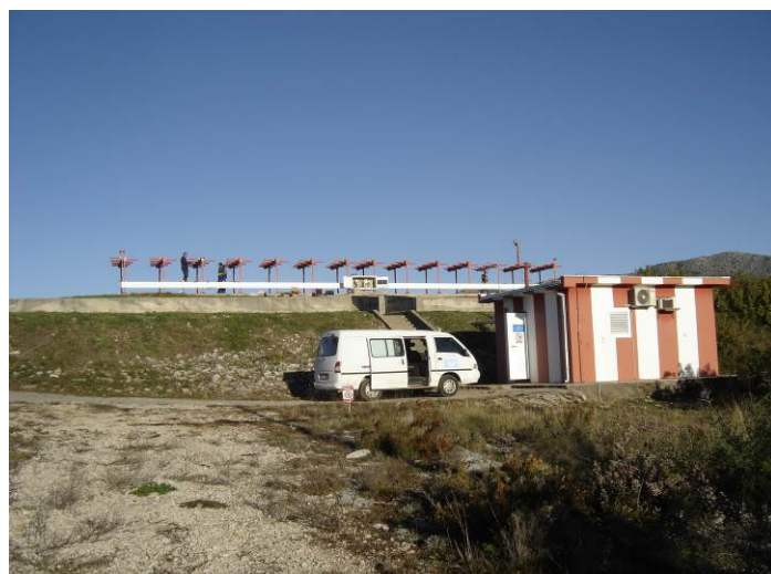
Prilog 94: Antenski sustav - LOKALIZER (ILS 12) (Izvor: Trames d.o.o., listopad 2012.)
