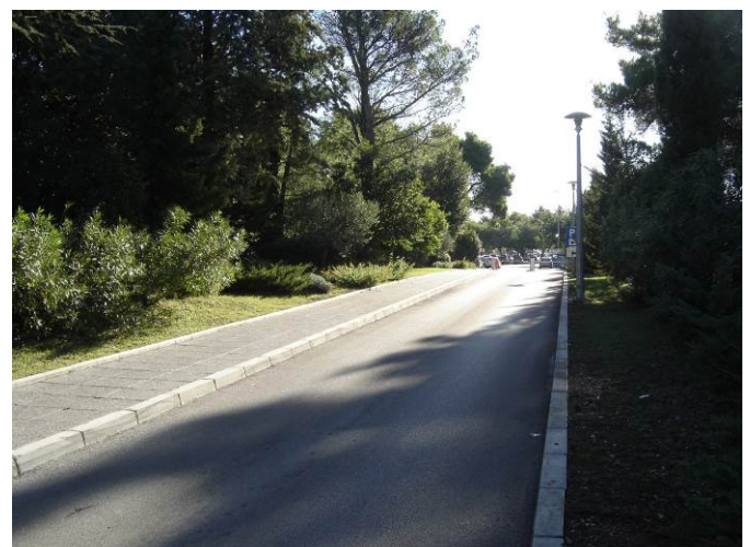
Prometnica za ulaz na glavno javno
