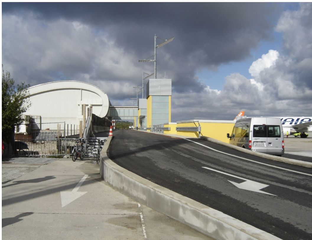
Prilog 27: Fotografije zgrade „B“, dilatacije „T“ (kolna površina i rampa) i prihvata aviomostova (Izvor: Trames d.o.o, listopad 2012.)
