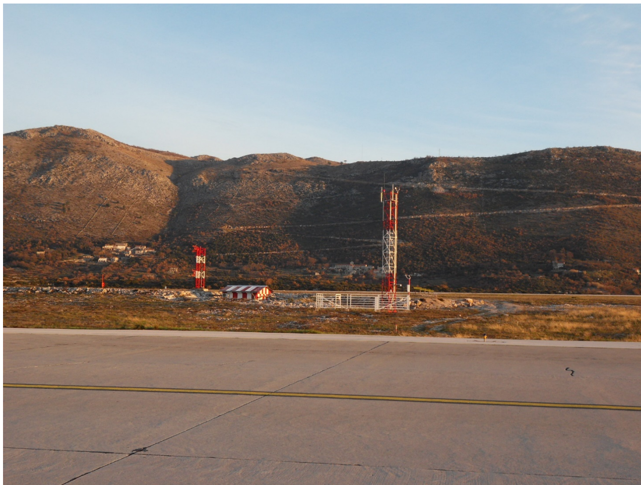
Prilog 93: Radio – navigacijski uređaji, posebno uređaj za određivanje pravilne ravnine poniranja zrakoplova na slijetanju, koji je dio sustava ILS («Glide Path») i automatska meterološka stanica na krajnjem sjeverozapadnom zelenom otoku (Izvor: Trames d.o.o.)
