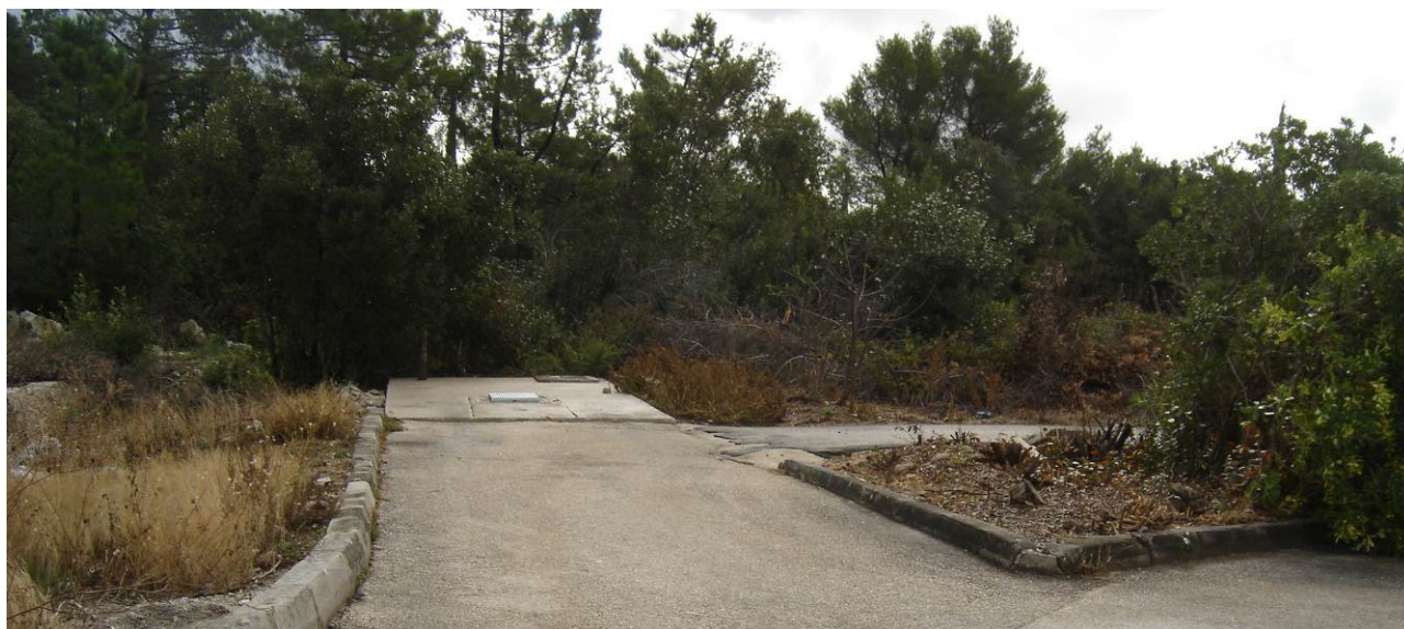
Prilog 37: Fotografija postojećeg podzemnog odlagališta zrakoplovnog fekalnog otpada (Izvor: Trames d.o.o, listopad 2012.)
