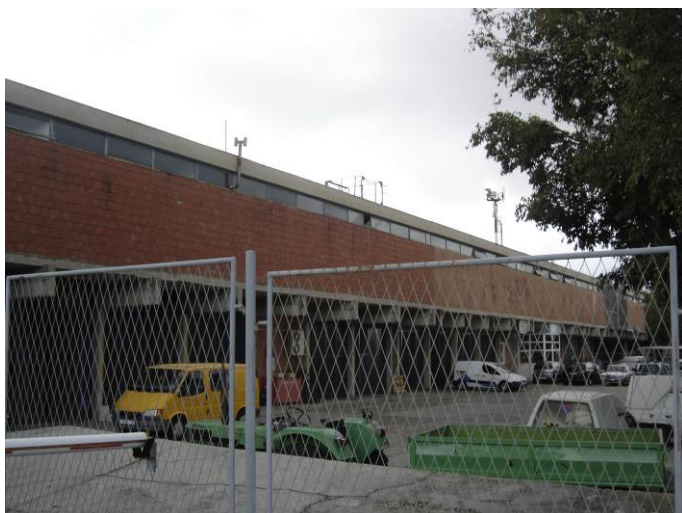
Spasilačko vatrogasna služba i garažno-tehnički blok (oznaka 7)
