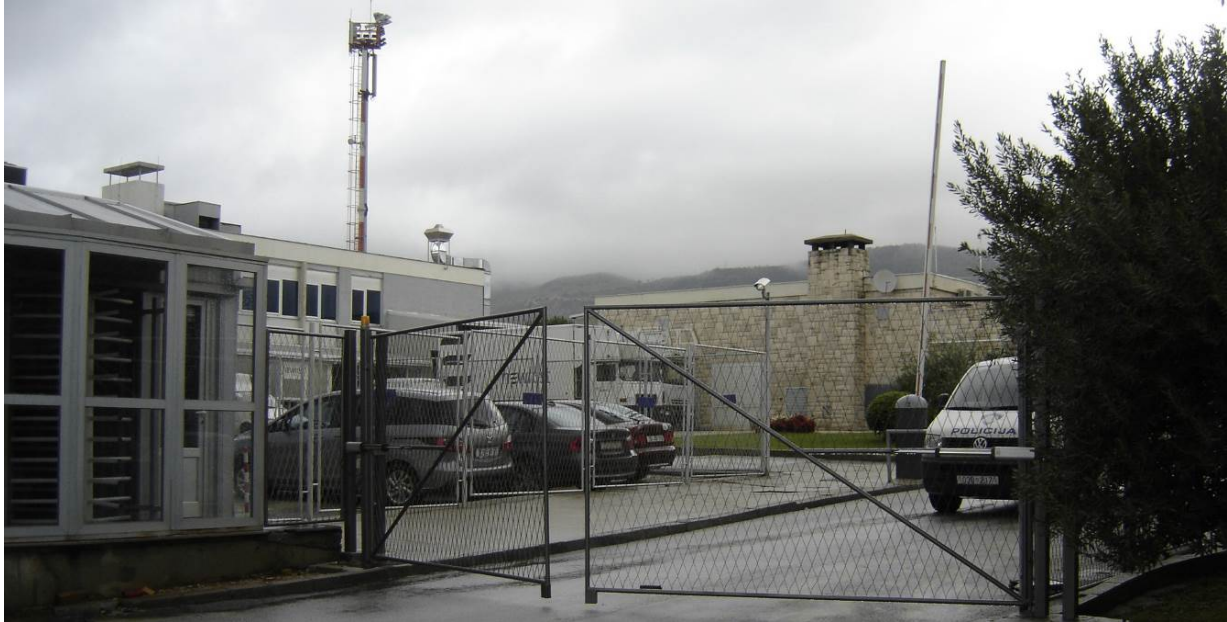
Prilog 31: Fotografija postojeće trafostanice (Izvor: Trames d.o.o. , listopad 2012.)
