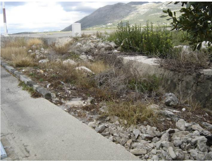
Prilog 95: Cjevovod oborinske kanalizacije na istočnom kraju stajanke opće avijacije - ispuštanje u okolni teren bez prethodne separacije masti i ulja. (izvor: Trames d.o.o., listopad 2012.)
