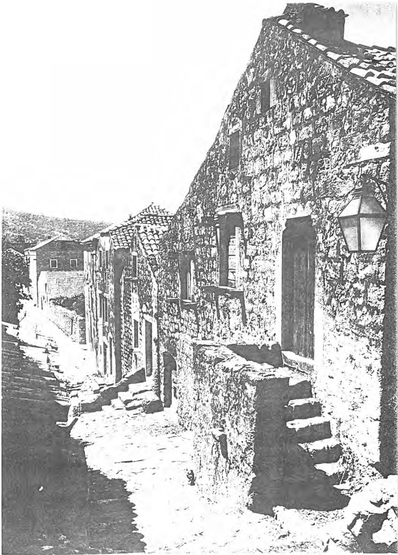
Ulica od mira - objekti IV-17,16,15,14,13
