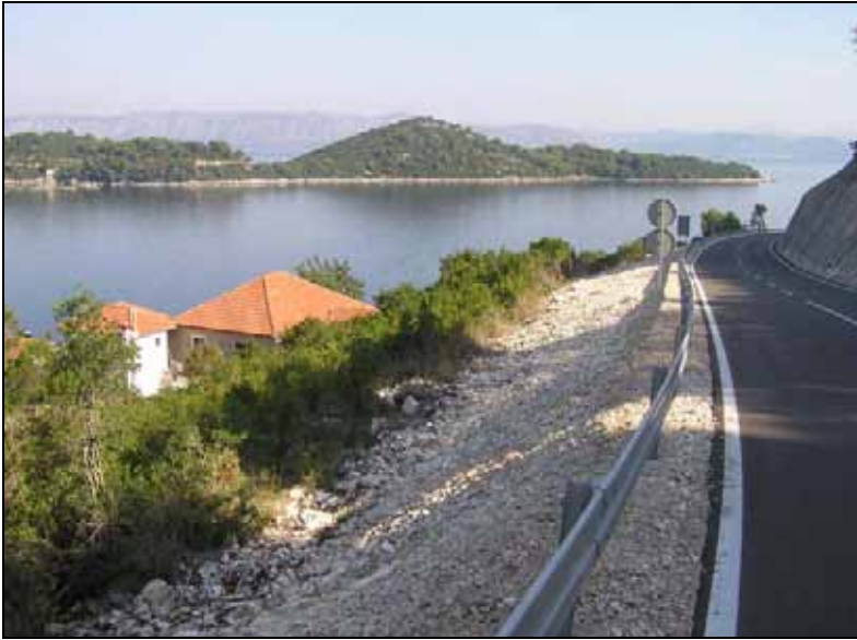
Slika 1-5-6 Pogled na zaobilaznicu odmah iznad zgrada naselja Sobra.
